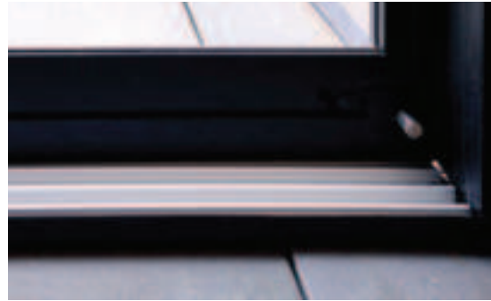
Selbsverriegelung | Bottom lock | Verrou inférieur
